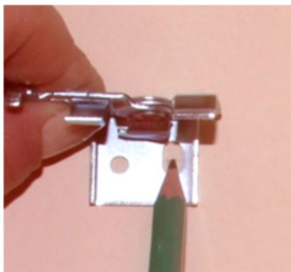
Расположите кронштейны равномерно по всей ширине отмеченной области. При этом обратите внимание, чтобы крепежные элементы не попали на внутренние узлы и механизмы карниза. Отметьте места для отверстий.
