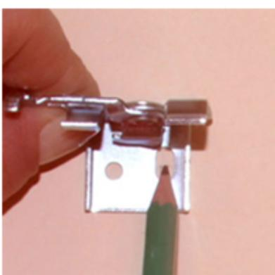
Расположите кронштейны равномерно по всей ширине отмеченной области. При этом обратите внимание, чтобы крепежные элементы не попали на внутренние узлы и механизмы карниза. Отметьте места для отверстий.
