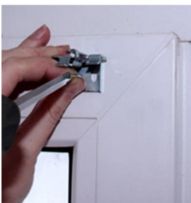
Прикрутите кронштейны саморезами через монтажные отверстия к стене раме.
