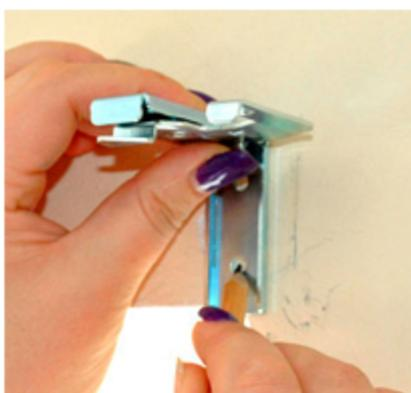
Расположите кронштейны равномерно по всей ширине отмеченной области. Отметьте места для отверстий.
