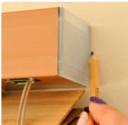
Для определения мест установки кронштейнов приложите изделие к стене или потолку, сделайте отметки с двух его сторон.
