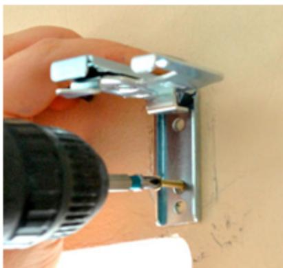
Прикрутите кронштейны саморезами через монтажные отверстия к стене или потолку.
