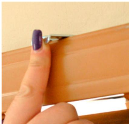
Отведите фиксаторы кронштейнов против часовой стрелки, вставьте карниз изделия в кронштейны и поверните фиксаторы кронштейнов по часовой стрелке до упора.
